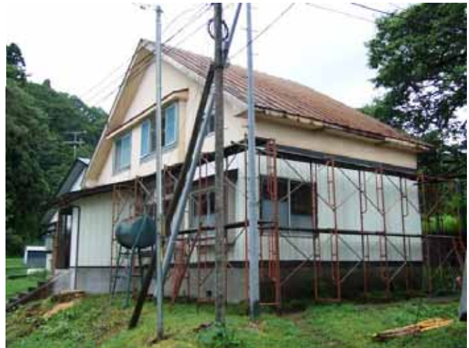
足場を組み立てて工事に着手した旧看護婦宿舍
