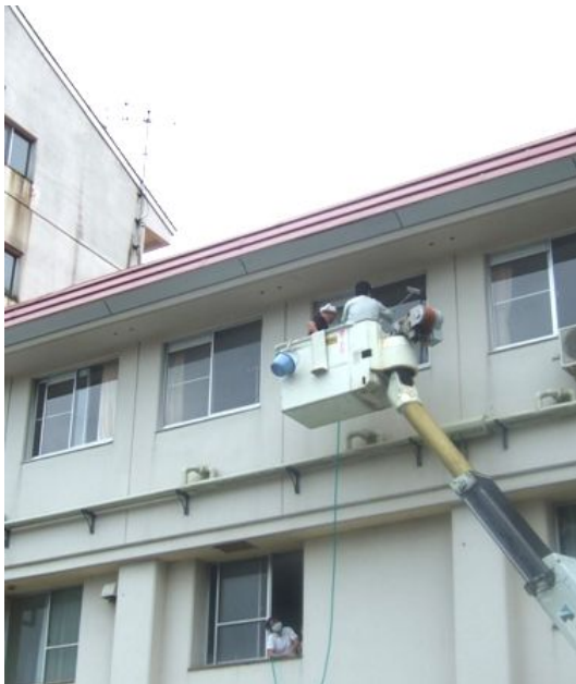
高所作業車に乗って病院3階の窓拭き作業
